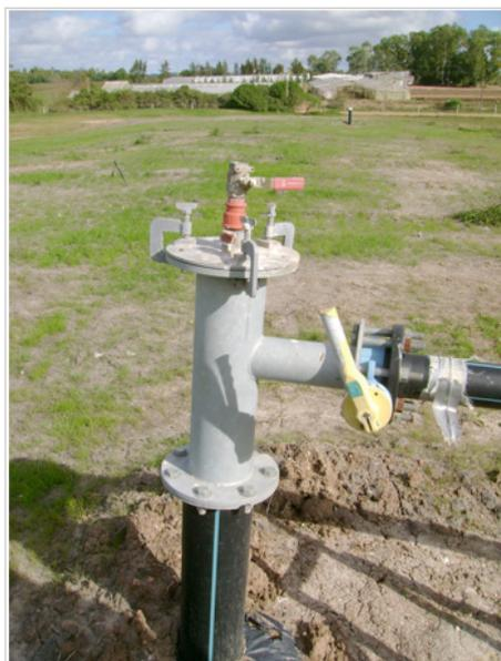
Figura D.39 - Cabeça de poço de captação de gás metano
