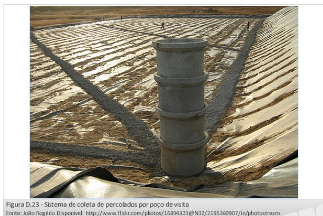
Sempre que possível, deve-se optar por fazer a descarga ou retirada do lixiviado do interior do aterro sem a utilização de bombas, uma vez que o uso desse tipo de equipamento sempre corresponde a uma fragilidade do sistema e leva à possibilidade de falhas. Quando a impermeabilização inferior for feita com geomembrana, cuidados especiais devem ser tomados, na passagem da tubulação de saída de lixiviados por esta camada.
