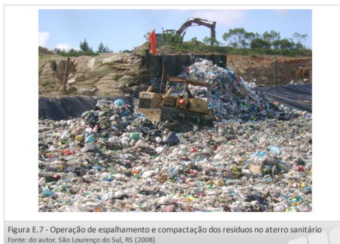
Figura E.7 - Operação de espalhamento e compactação dos resíduos no aterro sanitário
