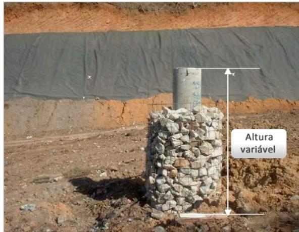
Figura D.30 - Método construtivo do sist. passivo de drenagem de gases de aterro
