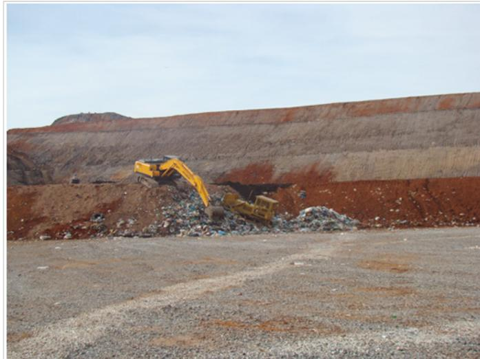
Figura C.20 - Operação de espalhamento e compactação de resíduos
