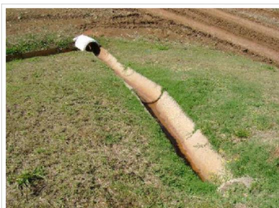
Figura D.13 - Sistema de drenagem pluvial permanente
