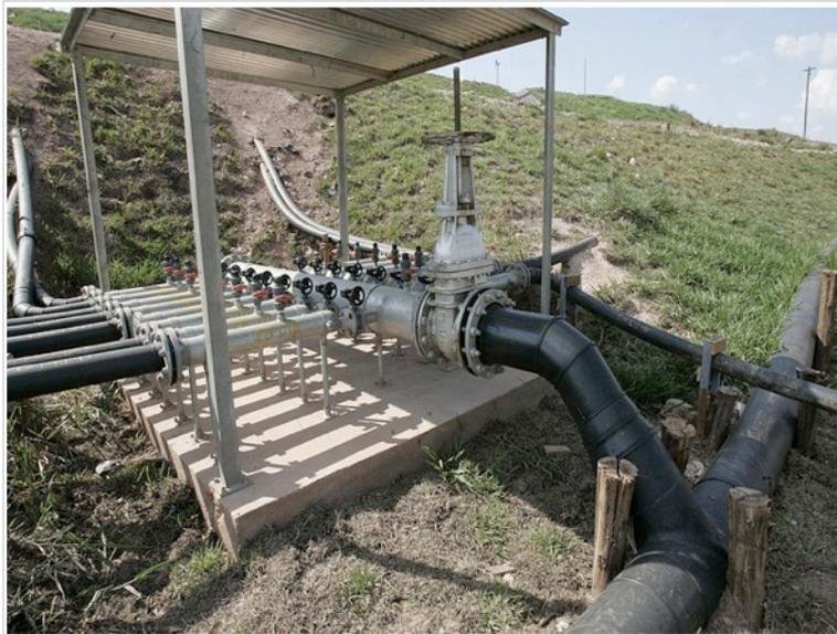
Figura D.40 - Unidade de controle do fluxo de gás metano (manifold)
