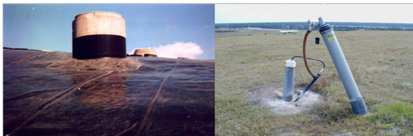
Figura D.35 - Características de poços de captação de gases de aterro do sistema ativo
