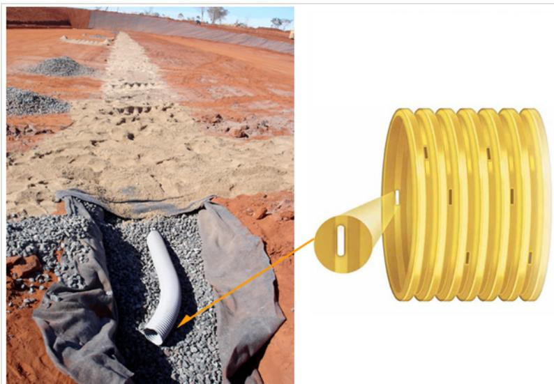
Figura D.21 - Colocação do dreno principal em sistema de drenagem do tipo colchão drenante
