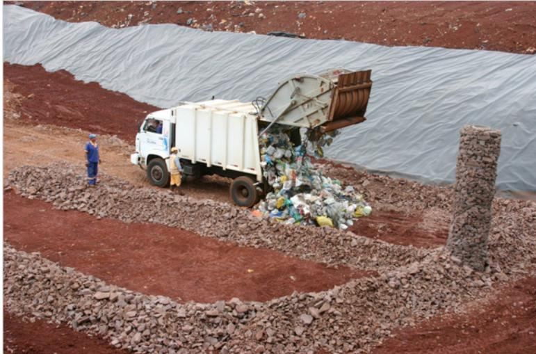
Figura C.4 - Sistema de drenagem de chorume em aterro sanitário
