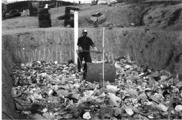
Figura E.9 - Operação de compactação de resíduos manual em aterros simplificados
