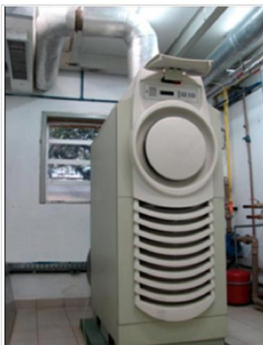
Figura D.44 - Microturbina de geração de energia
