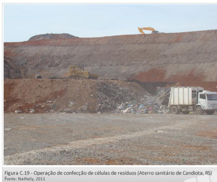
Figura C.19 - Operação de confecção de células de resíduos (Aterro sanitário de Candiotá, RS)
