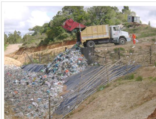
Figura E.6 - Operação de descarga de resíduos no aterro sanitário
