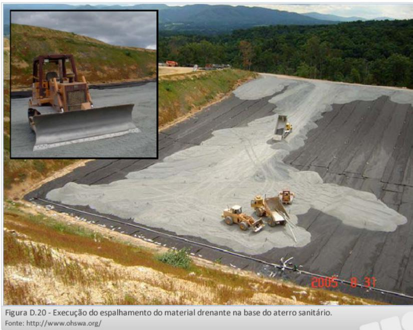
Figura D.20 - Execução do espalhamento do material drenante na base do aterro sanitário.
