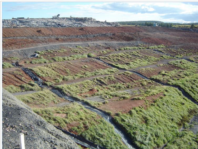
Figura D.12 - Sistema de drenagem pluvial provisório no aterro de Minas do Leão, RS (2007)
