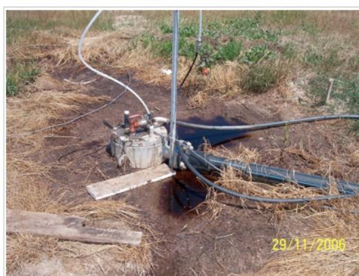
Figura D.42 - Chorume condensado após drenagem do gás de aterro
