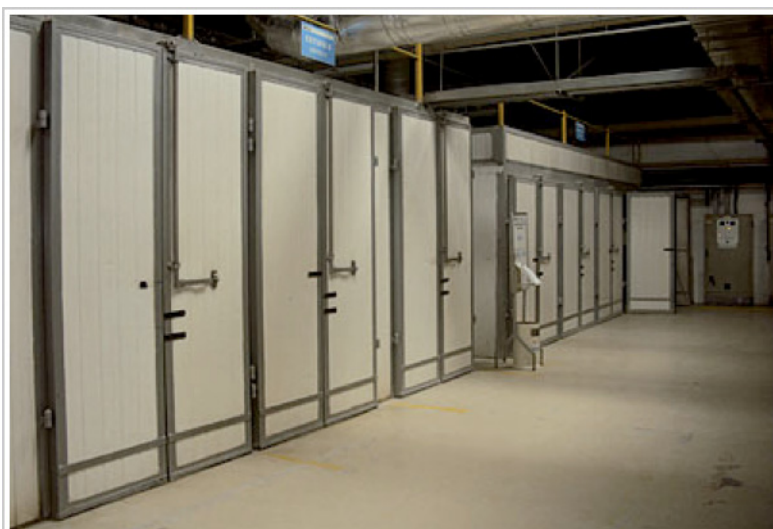
Figura D.14 - Secagem Fonte: site da revista Equipe de obra
