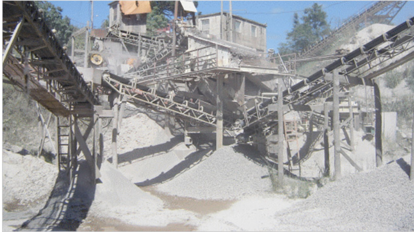
Figura C.3 : Visão geral do processo de britagem - Brita Pinhal Fonte: do autor
