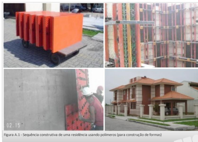
Figura A.1 - Sequência construtiva de uma residência usando polímeros (para construção de formas)
